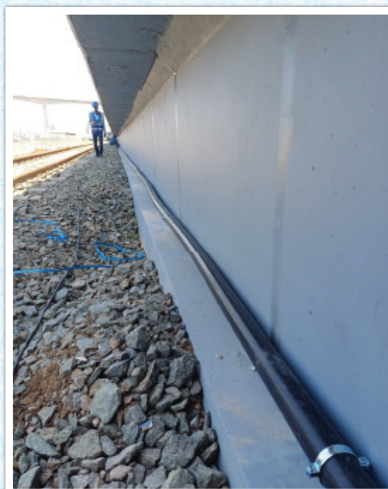
APOIADO NA PLATAFORMA
